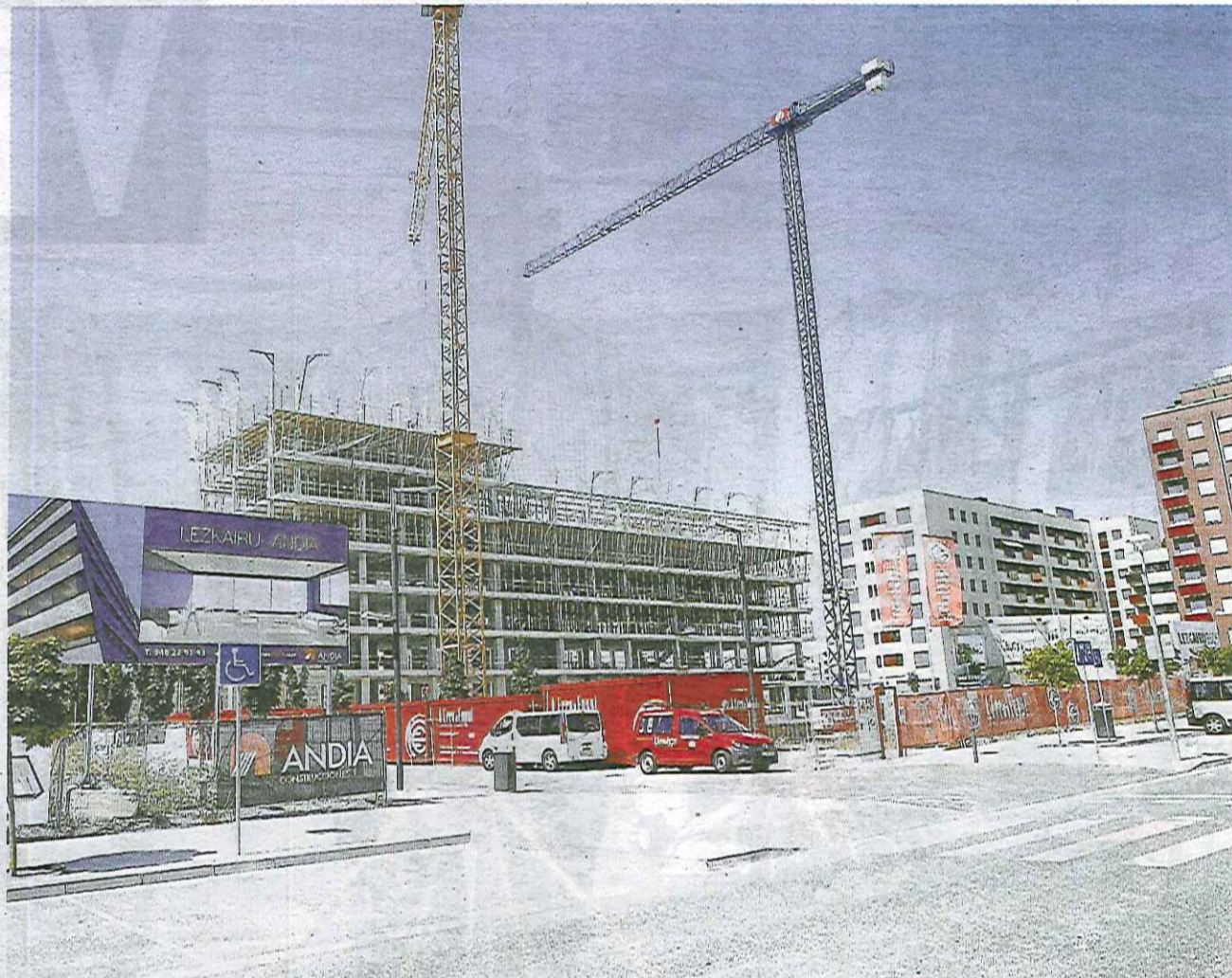
Grúas en marcha junto a la avenida de Cataluña, uno de los focos de actividad en el Soto de Lezkairu.
