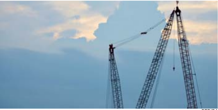
Grúas construyendo viviendas nuevas.
